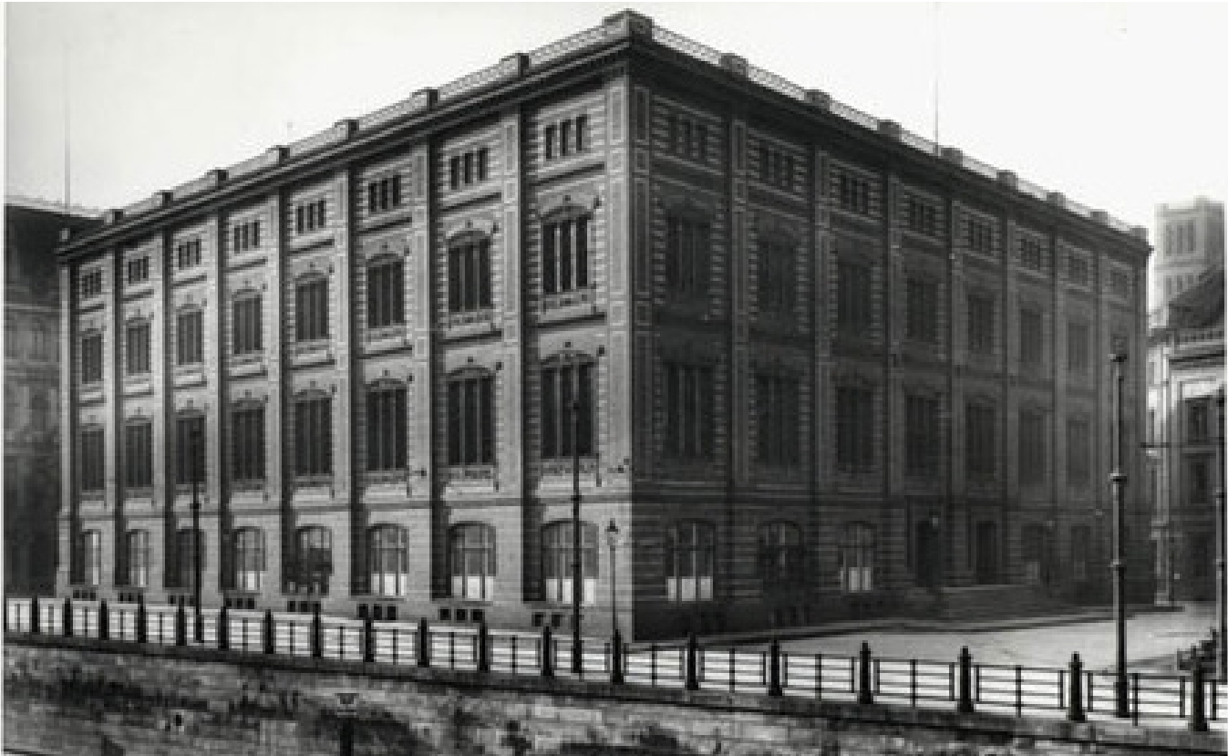
image 3.3.1 Photograph of Bauakademie Berlin source: https://www.bbr.bund.de/BBR/DE/BBR/Presse/Pressemitteilungen/2018/180507_wettbewerb_bauakademie.html
